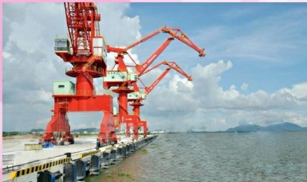
泊水域底标高近期按一万吨级疏浚至-10.1米，远期按三万吨级船型疏浚至-14.1米。本工程设计年吞吐量为91万吨，其中集装箱为9万TEU，件杂货为10万吨。另外二期工程码头后沿配套建设挡土墙及护岸结构约368米。目前，二期码头主体已完成土建工程及龙门吊岸吊设备的安装。经验收组评定，新会港二期码头主体顺利通过交工验收。
